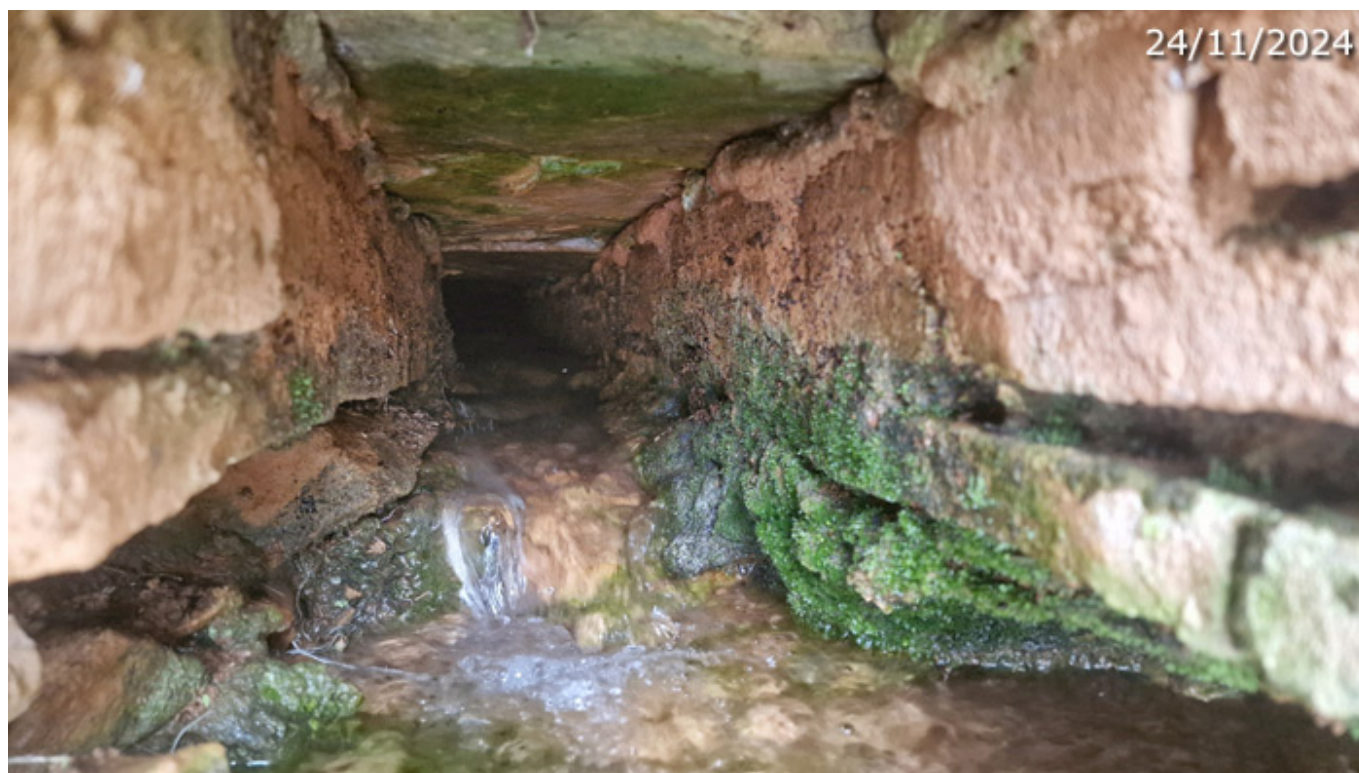
Interior de la atarjea del manantial por donde desagua el agua (A. Ventas, noviembre 2024)
