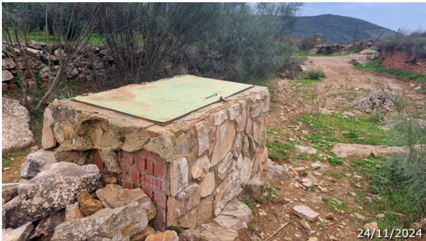
Pozo de abastecimiento que estaría captando las aguas del manantial (A. Ventas, noviembre 2024)
