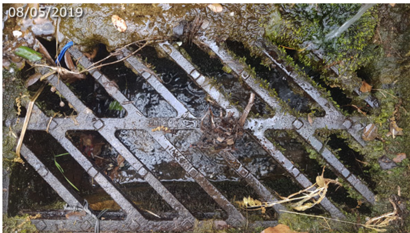
Alcantarilla por donde se vierte el agua sobrante de la fuente (A. Ventas. mayo 2019)
