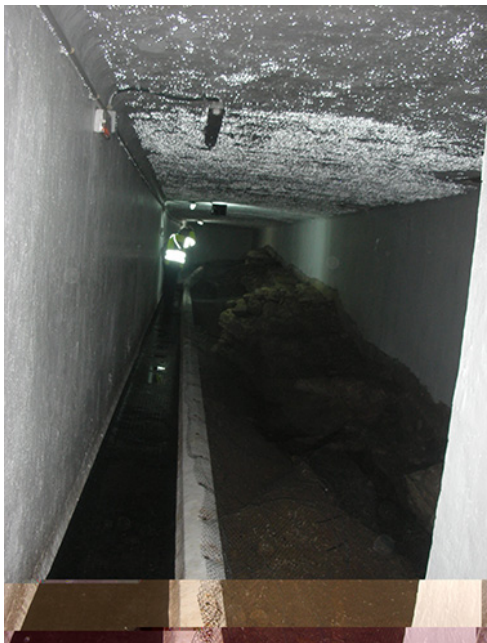
Nacimiento del Río Anzur, interior de la caseta (L. Sánchez Díaz, diciembre 2028)
