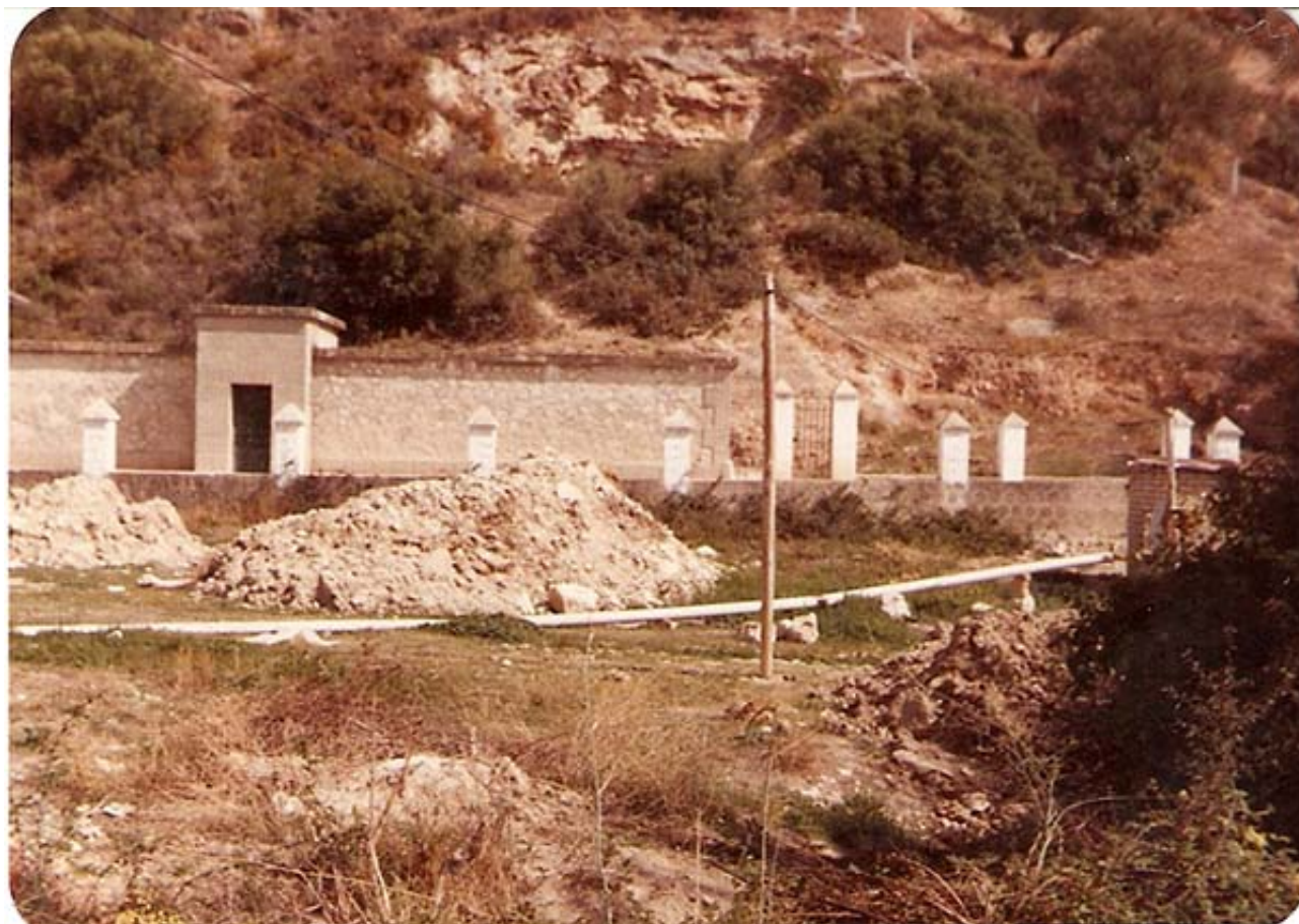
Caseta del manantial (G. Perandrés, 1996)
