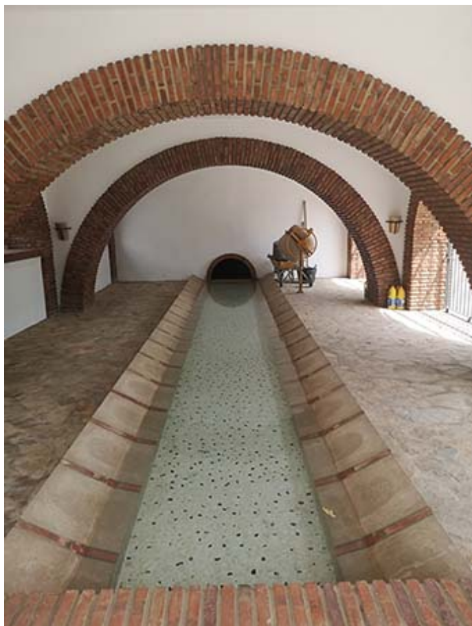
Interior del lavadero (J. Torres, agosto 2021)
