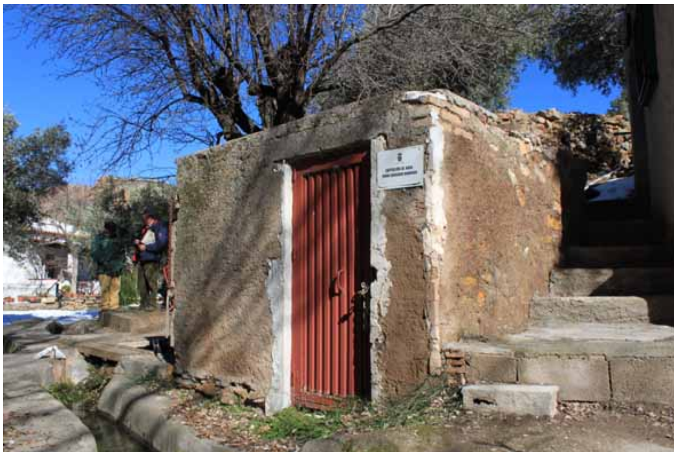
Caseta de distribución para abastecimiento de Serón (T. Peinado Parra, enero 2017)
