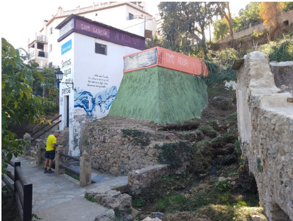
Caseta de captación (F. Cuesta López, octubre 2023)
