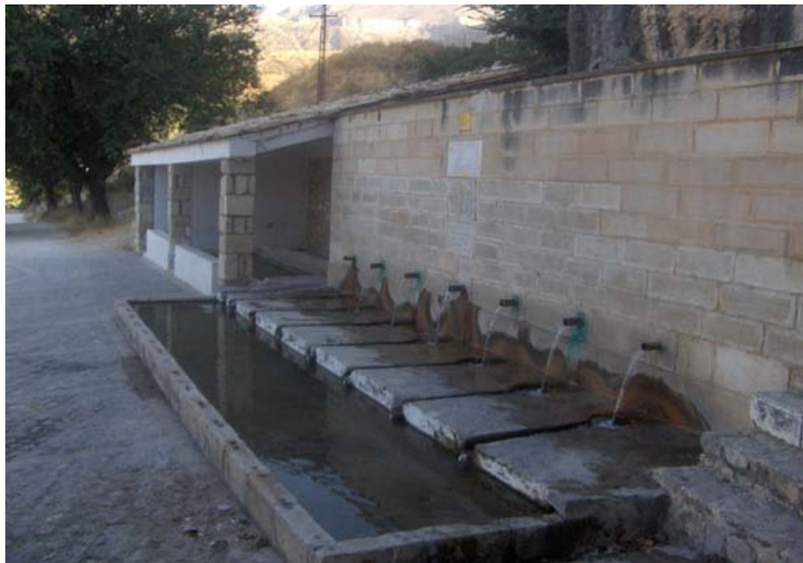
En primer plano Fuente de los Siete Caños, al fondo se encuentra el lavadero (L. Pereira Navarrete, agosto 2008)
