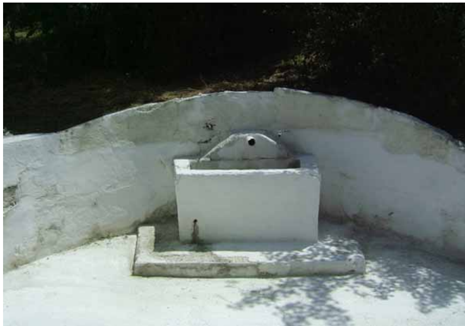
Detalle del antiguo caño, hoy seco, y de los grifos de agua potable puestos con posterioridad (F. Cuesta, 2006)
