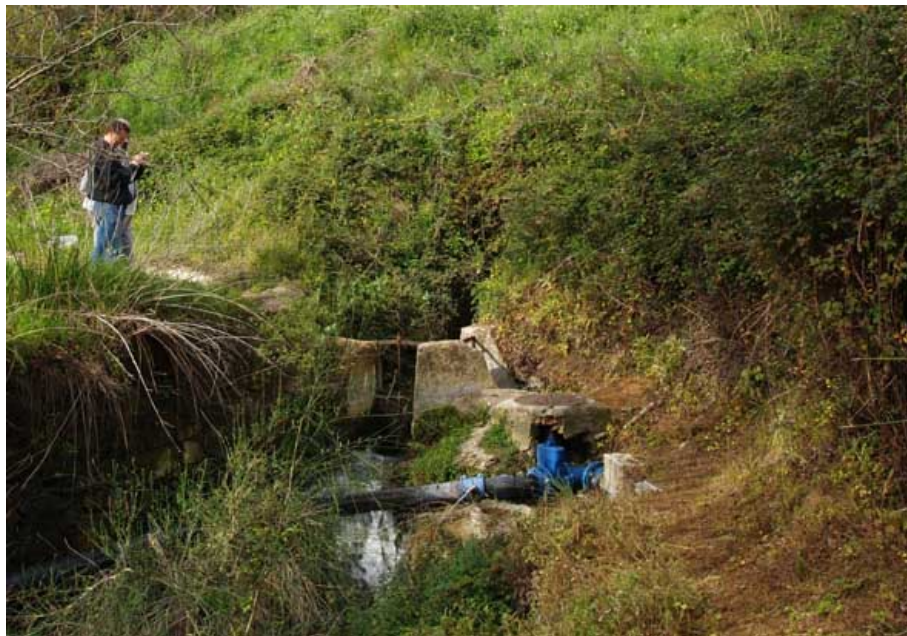
Vista del Nacimiento y de la tubería de abastecimiento a la localidad de Carratraca (C. Liñán, marzo, 2006)
