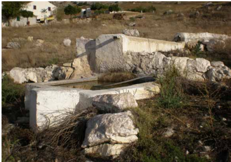
Vista completa de la fuente, con el pilón, la pequeña alberca y el cortijo detrás (A. Vela Torres, octubre, 2008)
