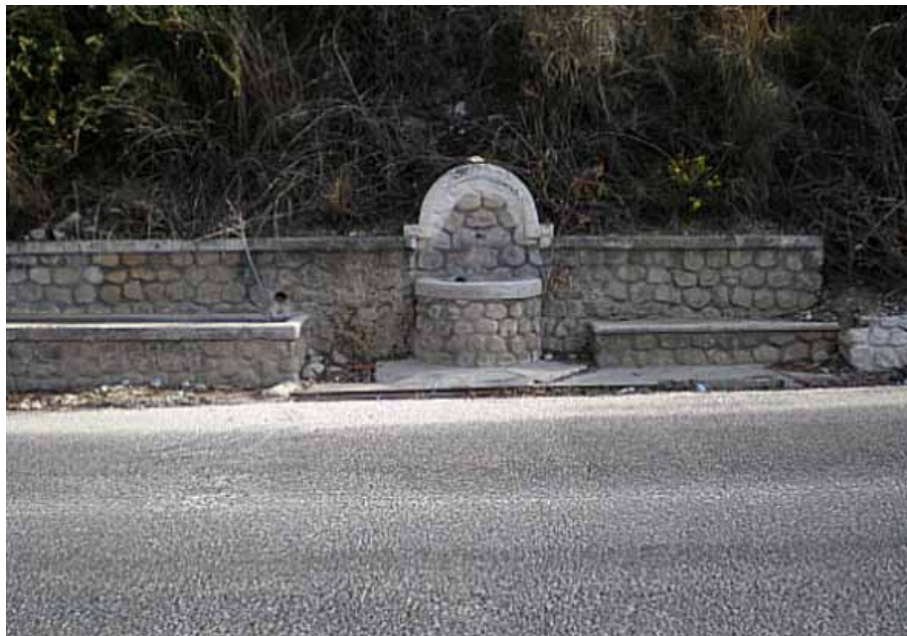
Imagen completa de la fuente, con el caño central, el pilón-abrevadero a la izquierda y el banco a la derecha (A. Vela Torres, octubre, 2008)
