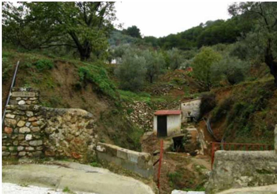
La Fuente de Magajuán, con las casetas que albergan los motores (A. Vela Torres, octubre, 2008)
