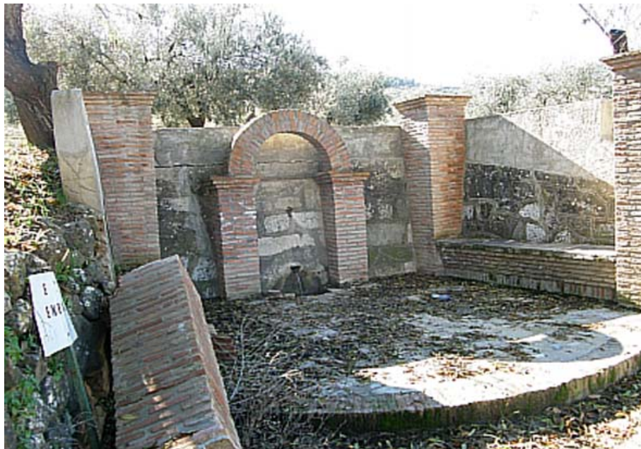
Fuente del Caño (A. Vela Torres, noviembre 2008)
