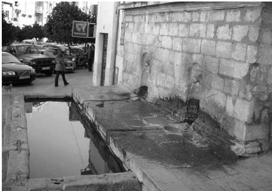
Fuente Pilar del Arrabalejo (J.A Palomino, diciembre 2008)
