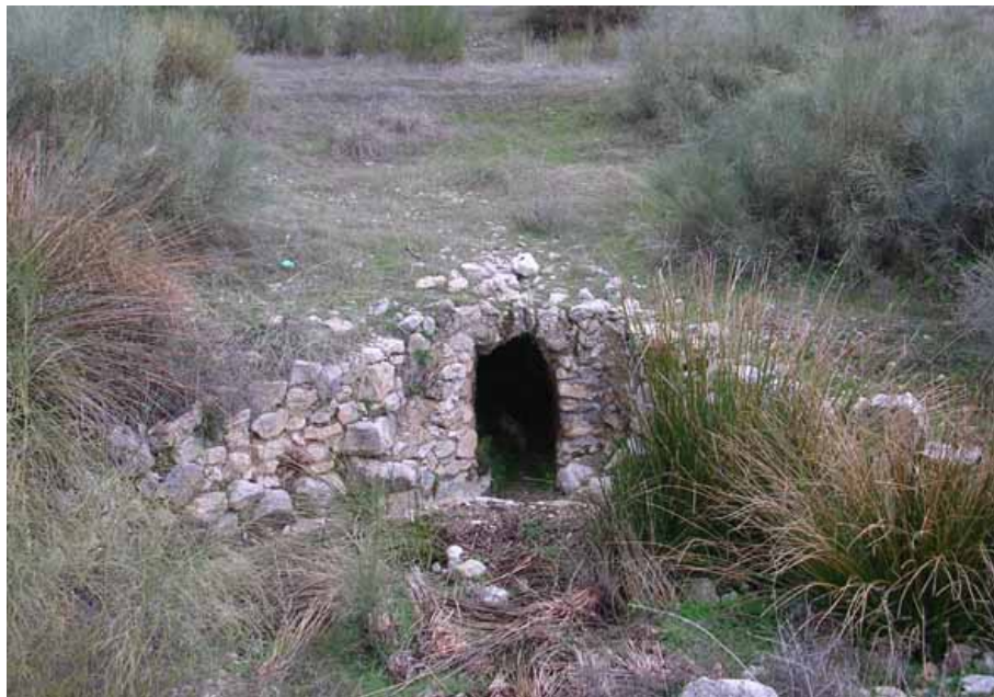
Vista de la galería que da acceso al interior de la fuente (D. Oya Muñoz, diciembre 2009)
