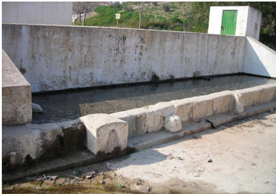
Abrevadero del Pilar (J. A. Palomino, febrero 2009)
