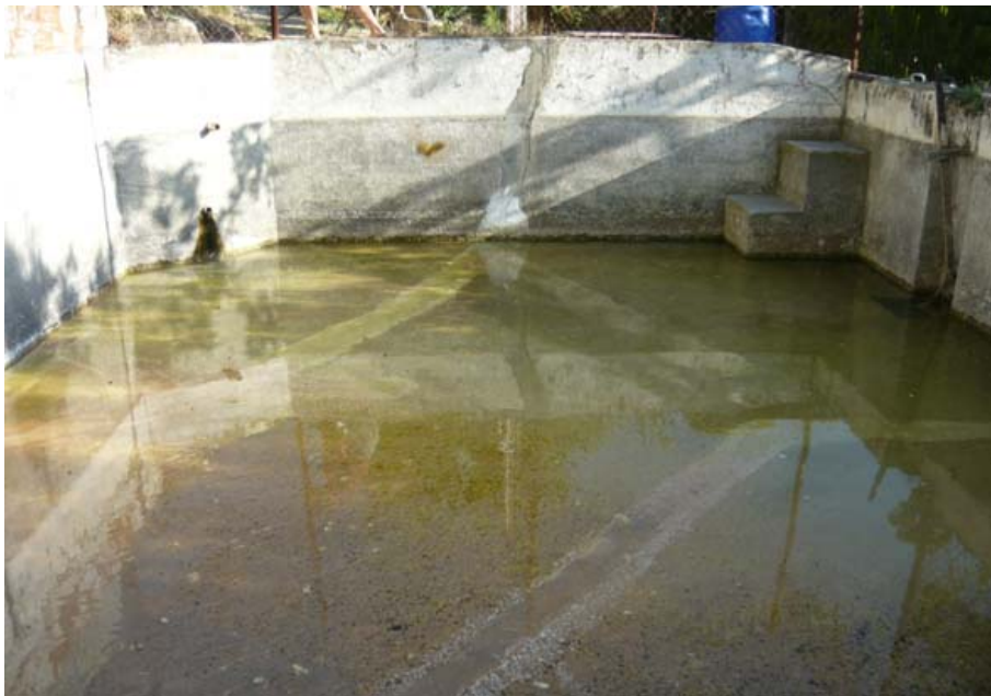
Alberca del manantial, a la izquierda, entrada de agua y a la derecha, escaleras de acceso y el curioso sistema de evacuación del agua (R. Raya Urbano, agosto 2010)
