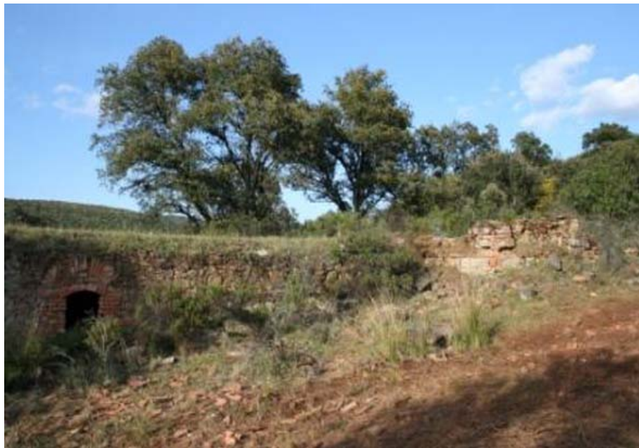
Detalle de la cara sur del extremo este de las ruinas del kiosko de La Lastra (V. Rodríguez Estévez, abril 2009)
