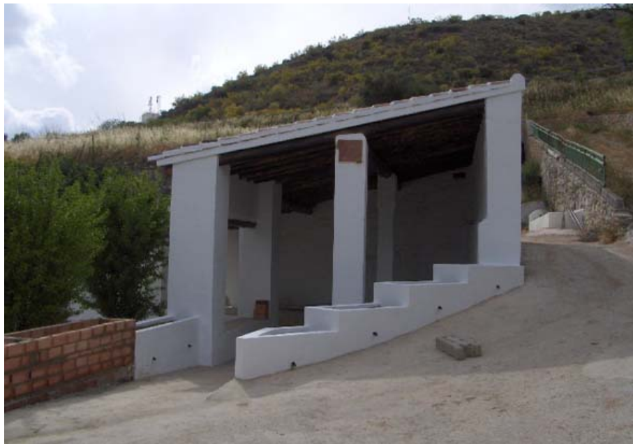
Fuente-Lavadero Municipal de Atajate (S. Rodríguez, junio 2009)
