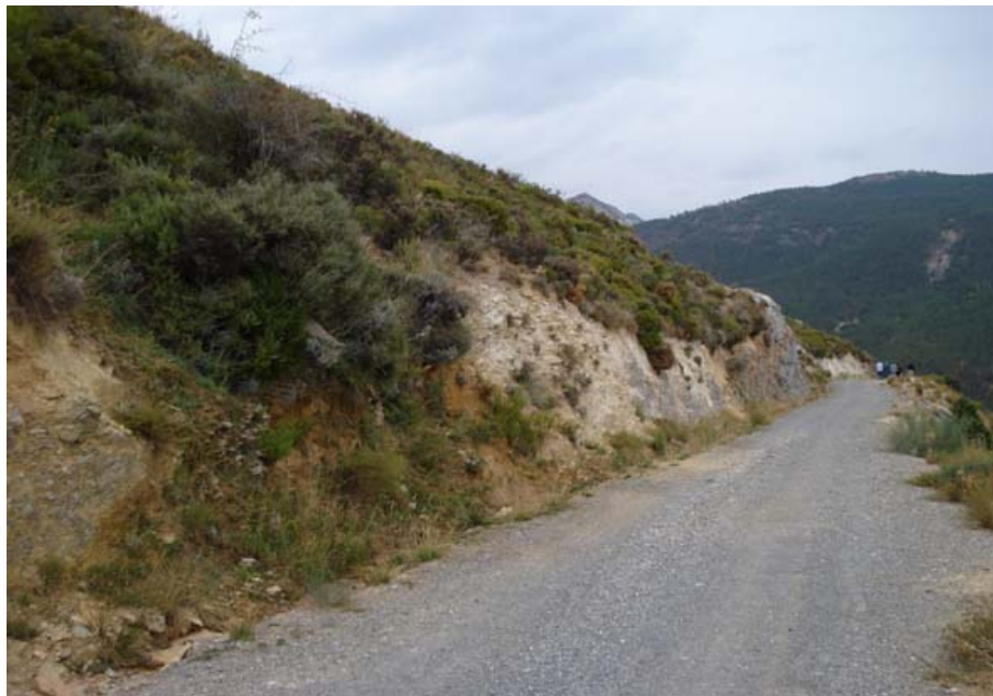
Vista del talud por el que discurre el agua de la Fuente de las Cebailas (J. A. Miranda, septiembre 2009)
