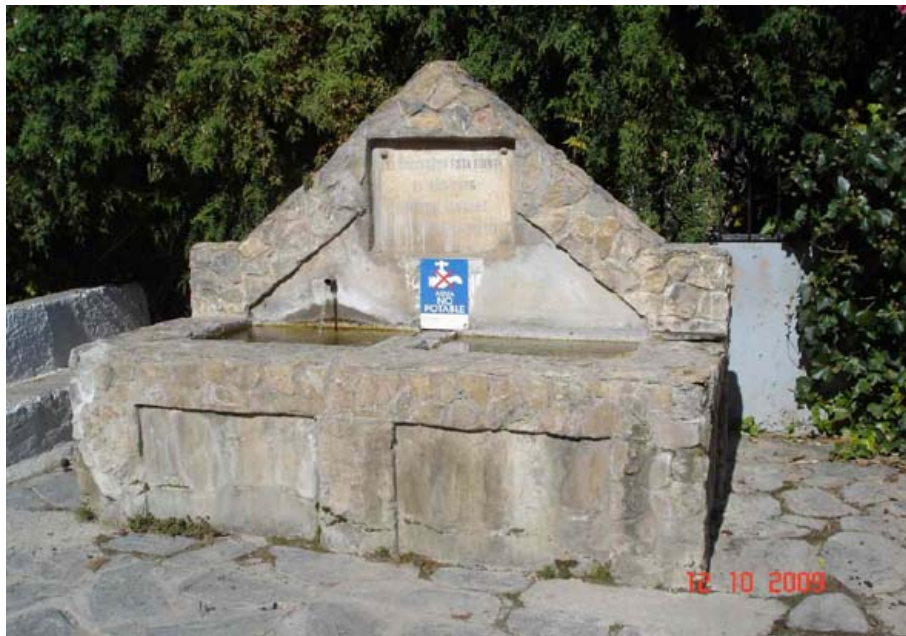
Fuente del Puente (J.Martín Jiménez, octubre 2009)
