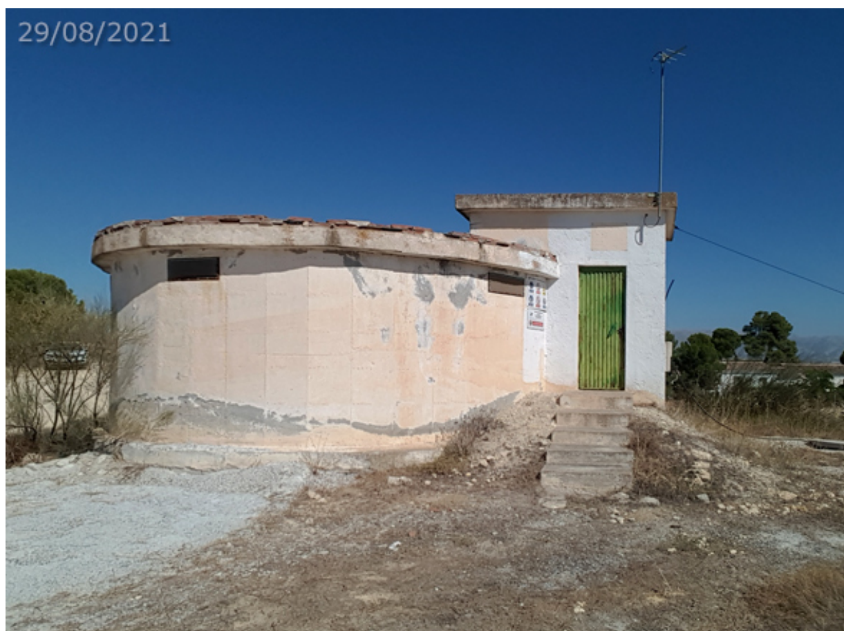
Depósito de abastecimiento de la población (A. Ventas, agosto 2021)
