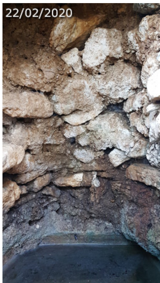
Interior de la Fuente de Pospítar, mostrando el empedramiento (A. Ventas, febrero 2020)
