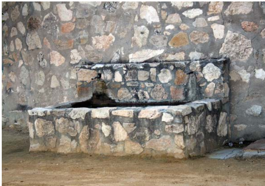
Pilar (F. Serrano Garcia, septiembre 2009)
