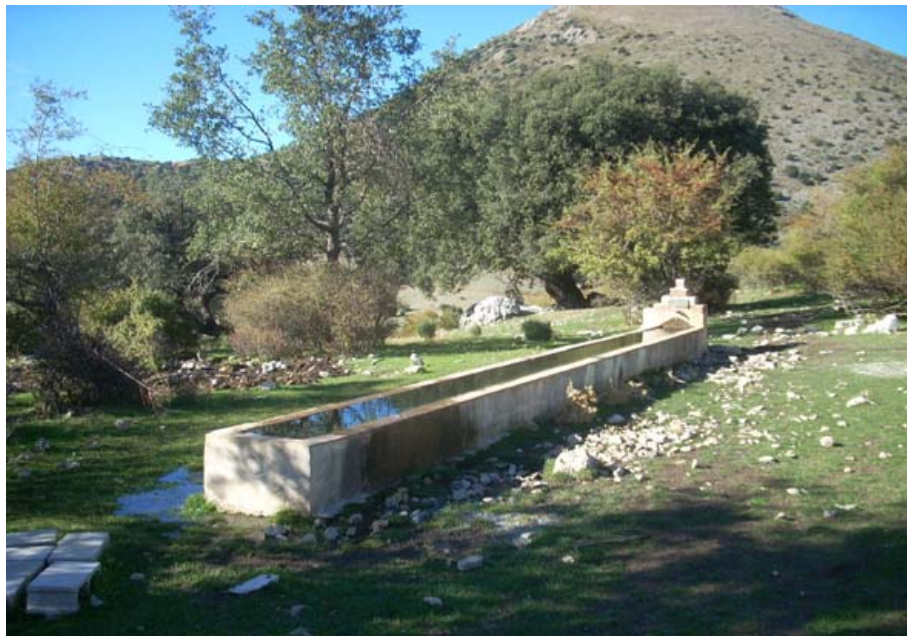
Pilar abrevadero Cortijillo las Rastras (D. Oya Muñoz, octubre 200),
