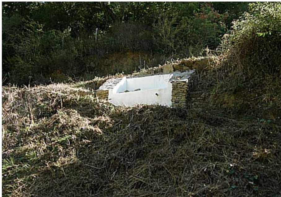
Depósito en el que fluye el manantial Autor: Antonio Vela Torres Fecha: 17-10-2009
