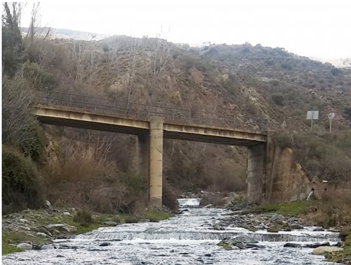
Salida supuesta de las aguas sobrantes de la fuente al río, a la derecha en la imagen cerca del puente (M. Moreno, marzo 2018)
