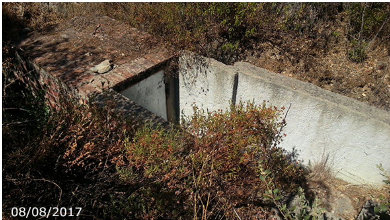
Vista superior de caseta de la fuente, encajonada entre el barranquillo (A. Ventas, agosto 2017)
