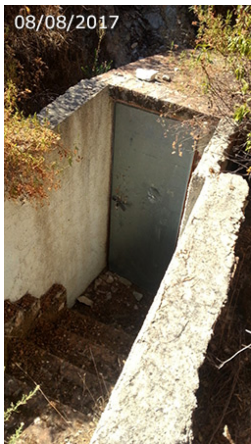
Escalera de acceso a la fuente, en caseta (A. Ventas, agosto 2017)
