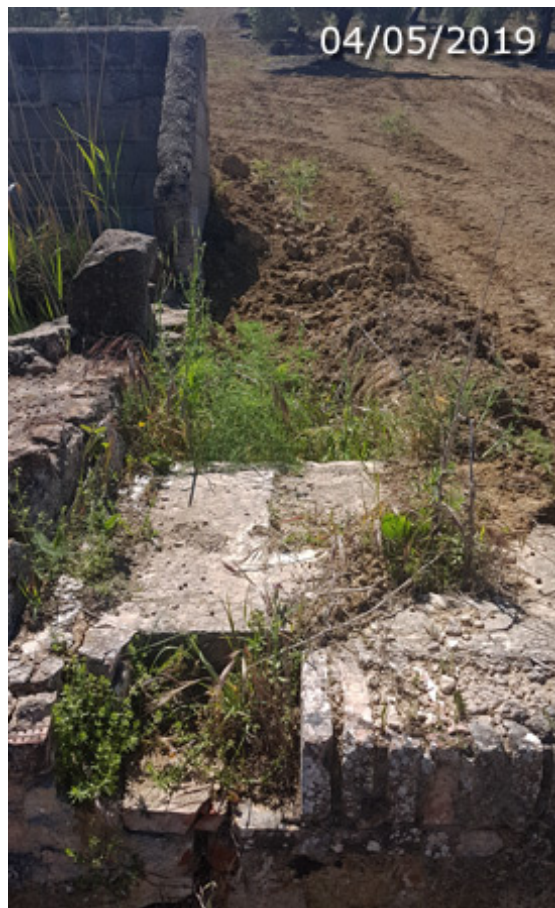
Detalle del enterramiento del pilar que quedaría a lo largo de la alberca (A. Ventas. mayo 2019)
