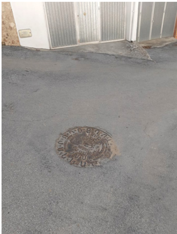
Tapadera de hierro sobre el nacimiento en la calle (J. Torres Castillo, abril 2020)
