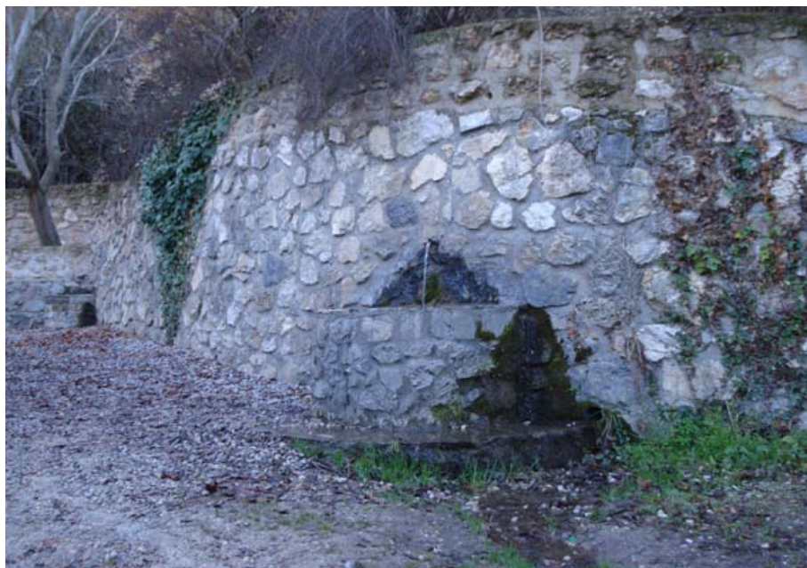
Pilarillo de la Central Hidroeléctrica de Tranvías (V.M. Robles-Arenas, diciembre 2009)
