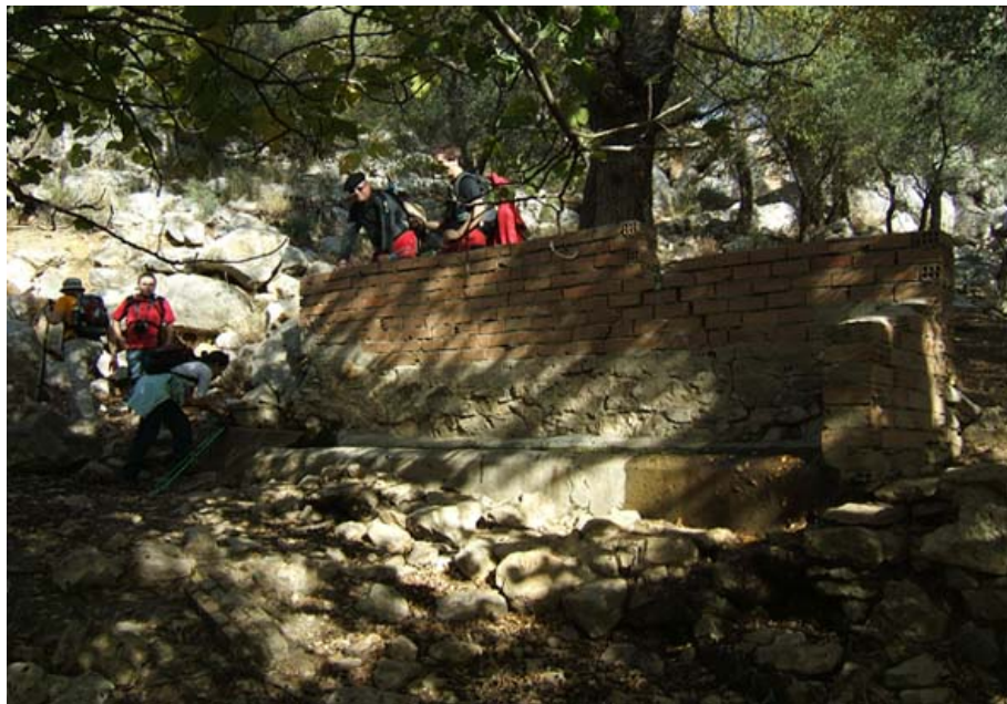
Fuente del Cortijo de Parriña, vista lateral y muro de contención (F. Cuesta López, diciembre 2009)
