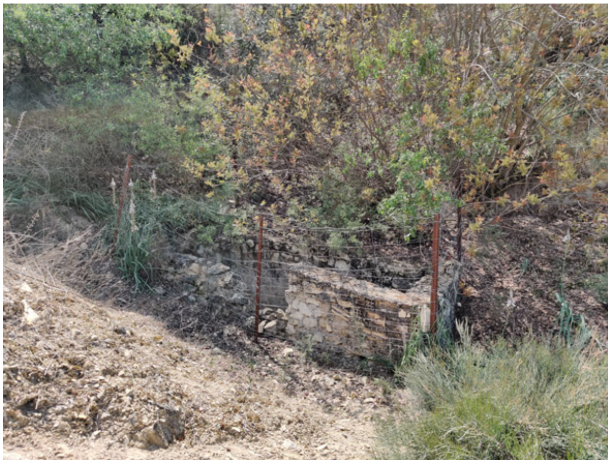
Detalle del brocal del pozo donde se encuentra el minado (D. Sánchez Garrido, abril 2021)
