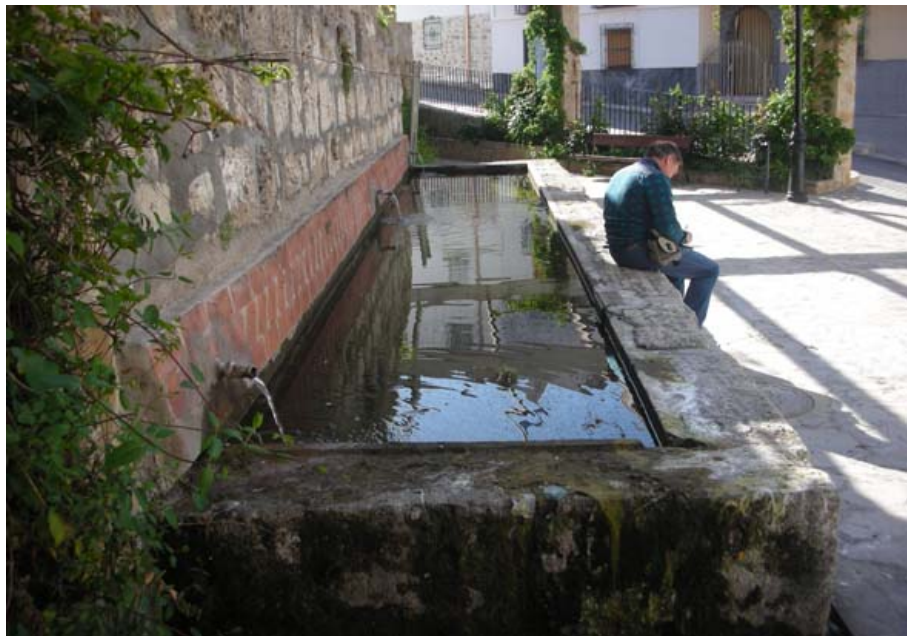
Fuente del Pilarillo (L. Sánchez-Díaz, abril 2015)
