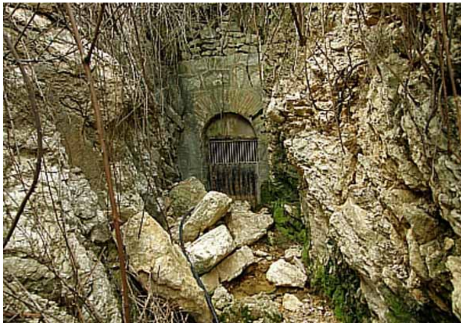
Entrada a la mina de agua de Vasijas (A.Vela Torres, marzo 2010)
