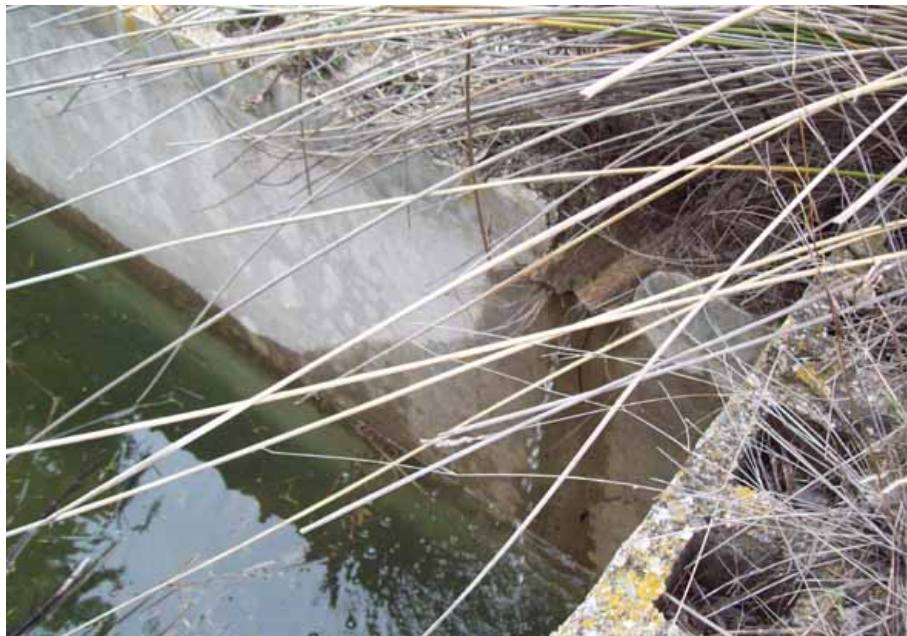
Mina del Barranco de Aix, detalle alberca (Club Deportivo Nueva Aventura de Oria, marzo 2010)
