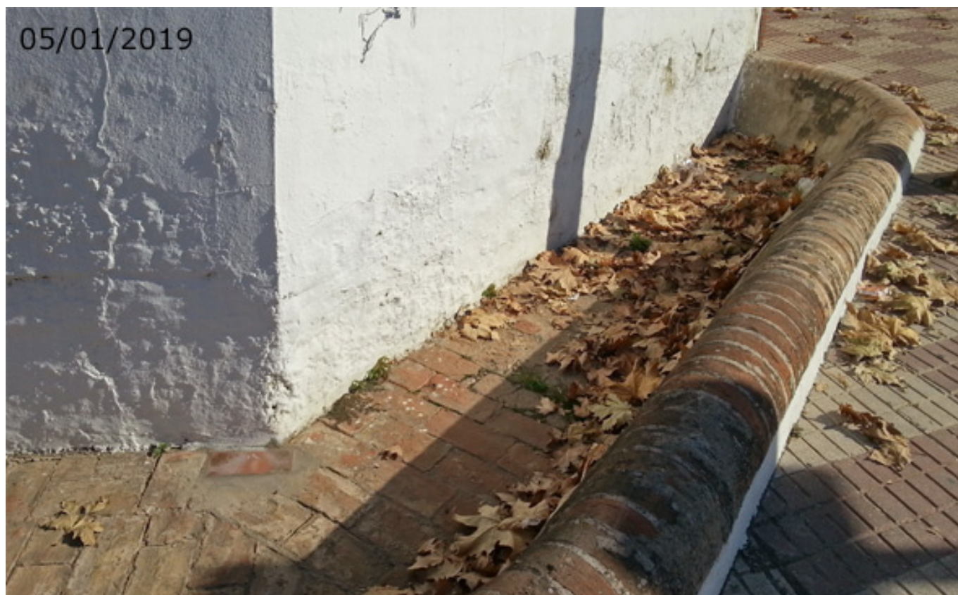
Abrevadero en su parte final, tras la esquina (A. Ventas. enero 2019)
