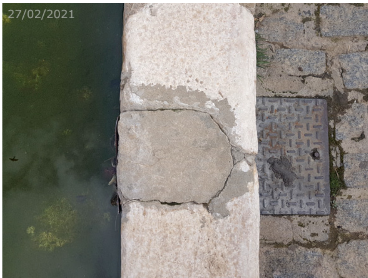
Pared del rebosadero, con la arqueta de salida en la calle (A. Ventas, febrero 2021)
