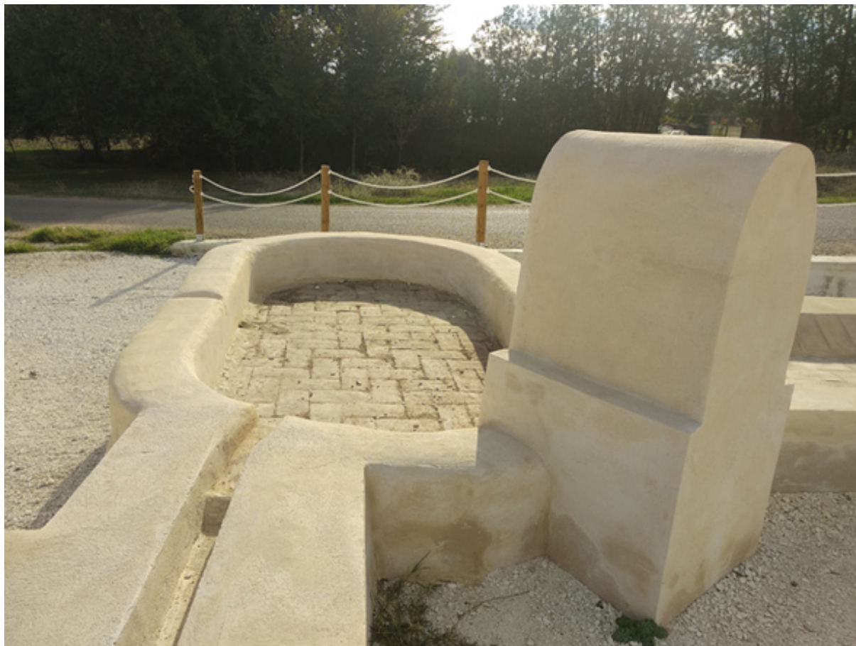
Fuente Mala, restauración del pilar (F. Cuesta López, noviembre 2021)
