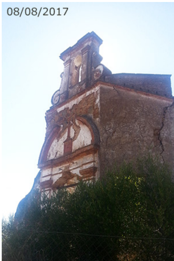
Ermita en ruinas a pie del inicio del camino de la estación (A. Ventas, agosto 2017)
