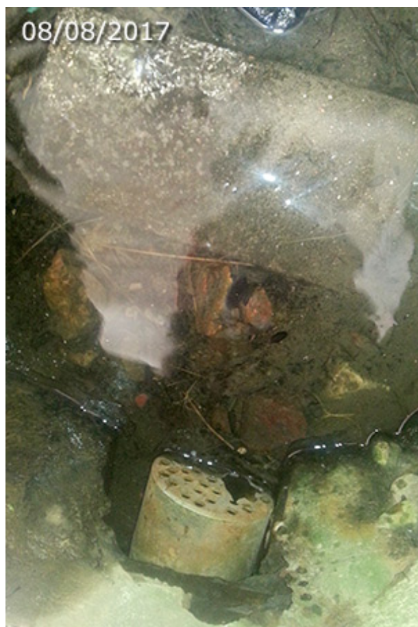
Desagüe de la pila encastrada en el suelo (A. Ventas, agosto 2017)
