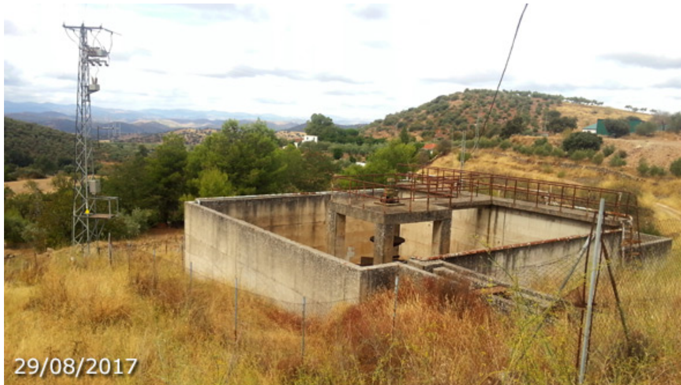
Estación de depuración de aguas en desuso, a sus pies está cerca la fuente (A. Ventas, agosto 2017)
