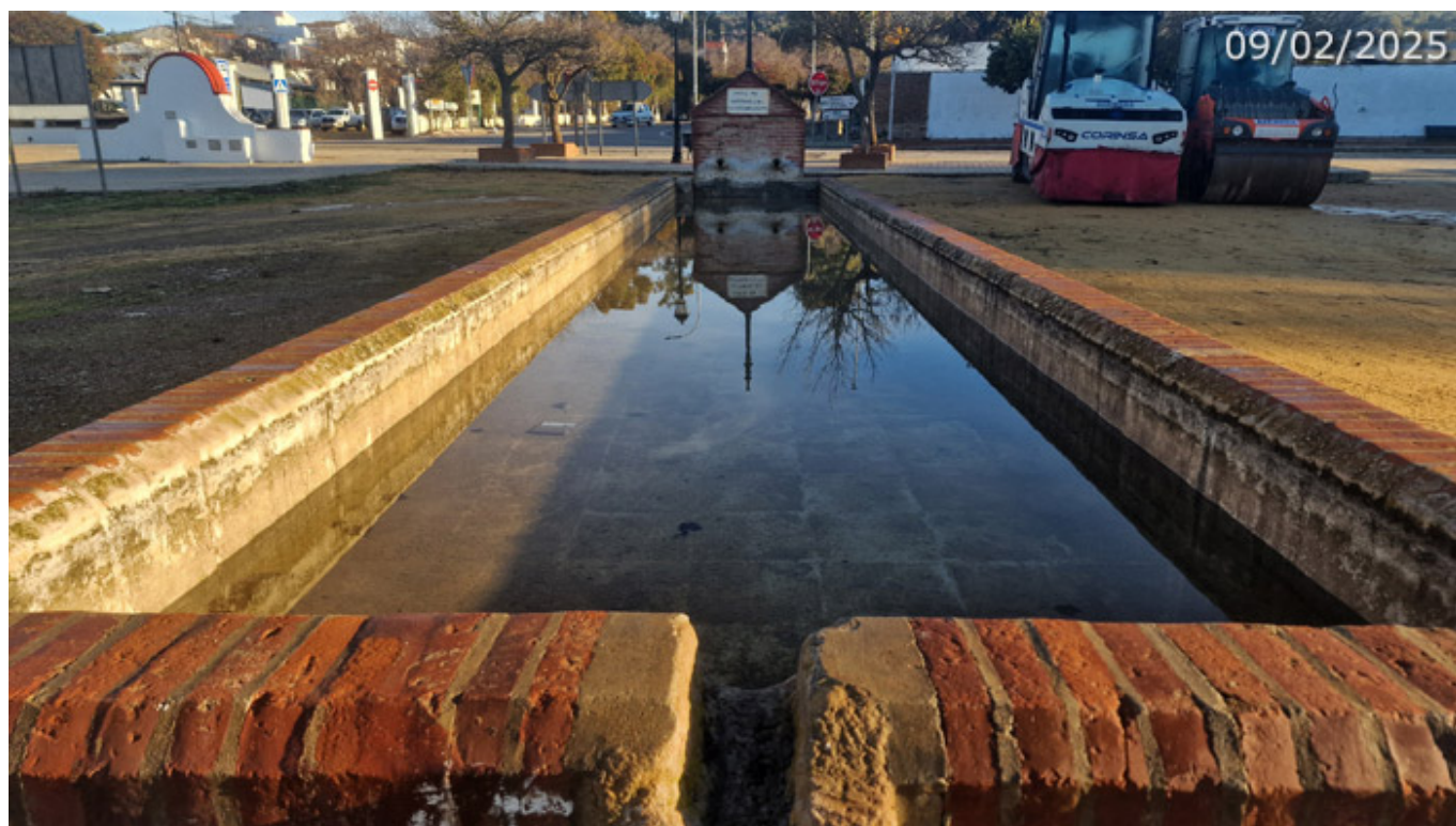
Pilar visto desde su rebosadero, con la fuente de El Coso en la esquina superior izquierda (A. Ventas, febrero 2025)
