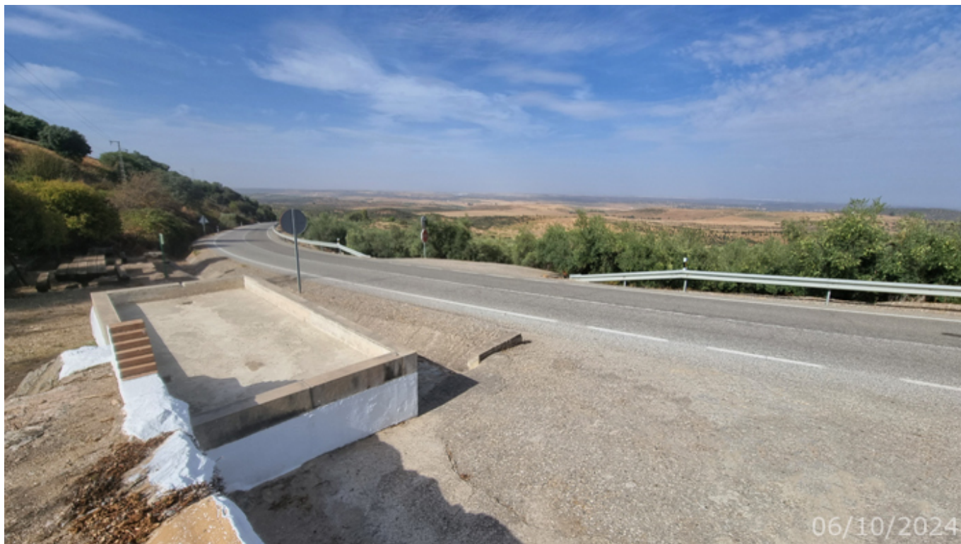
Pilar ante las preciosas vistas extremeñas desde el Puerto de Llerena (A. Ventas, octubre 2024)
