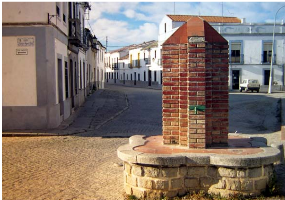
Fuente del Cerrillo (R. Córdoba, diciembre 1998)
