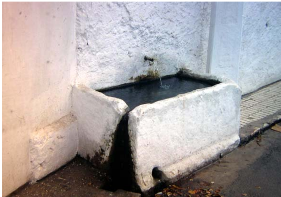
Pilar del Puente (R. Córdoba, diciembre 1998)
