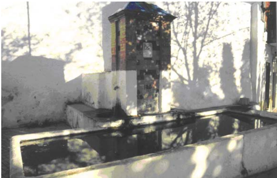
Fuente de la Estación (R. Córdoba, 1998)
