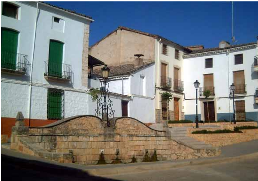
Fuente Los Caños (R. Navarro, noviembre 2005)
