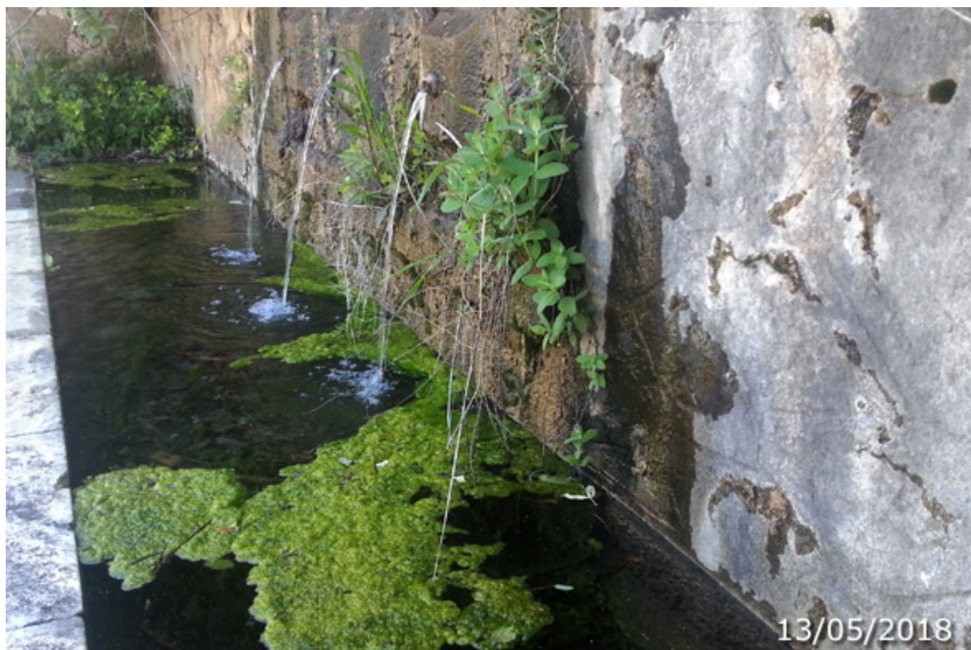
Los 3 caños del pilar junto a la carretera HU-8105 (A. Ventas, mayo 2018)
