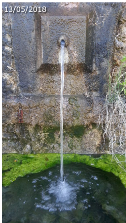
Detalle de uno de los caños del pilar junto a la ctra. HU-8105 (A. Ventas, mayo 2018)
