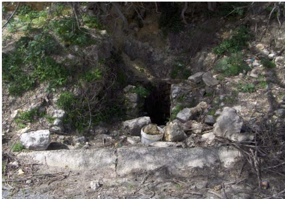
Estado exterior de la fuente, con su brocal abierto (S. Rodríguez, mayo 2010)
