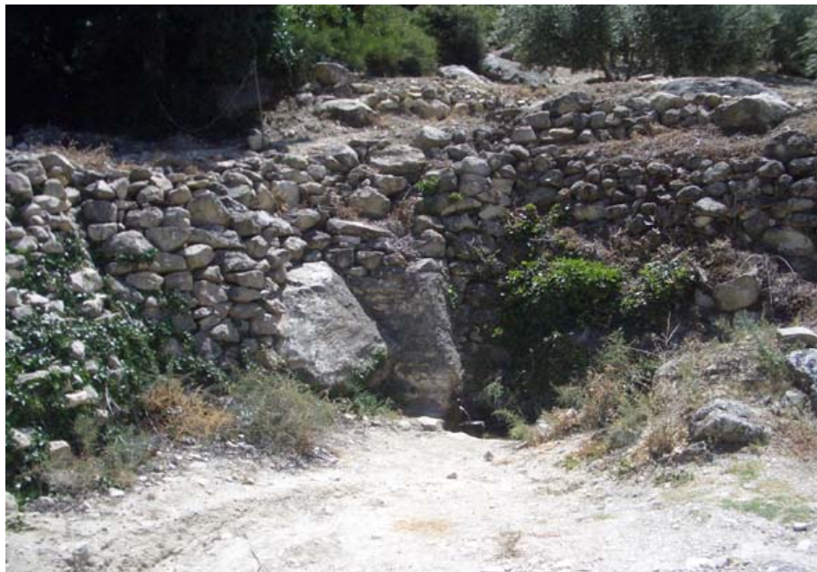
Fuente Los Casares, vista general (R. Quesada, junio 2010)
